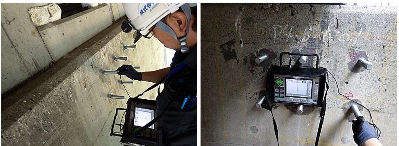
アンカーボルト長さ測定状況
