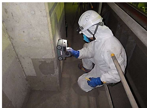
鉄筋探査状況
